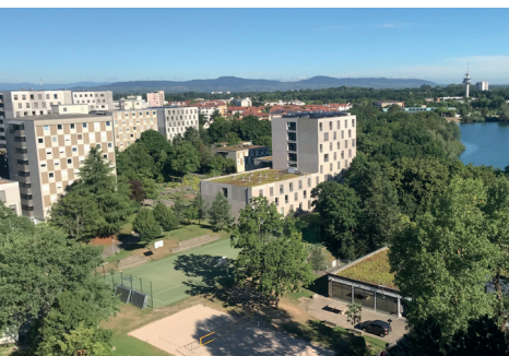
Begrünte Dächer und Photovoltaikanlagen in der Studentensiedlung am Seepark (StuSie)
